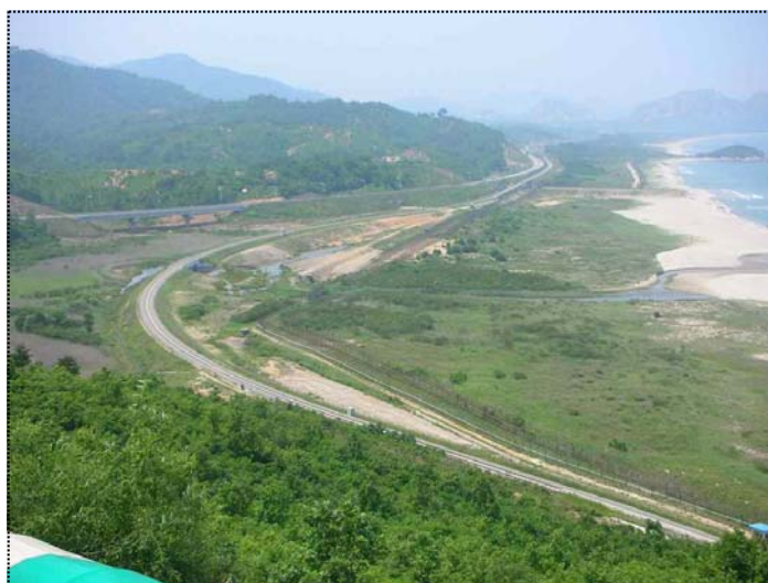
～ 金剛山に向かって伸びる東海線～ (手前が鉄道、奥が道路)
